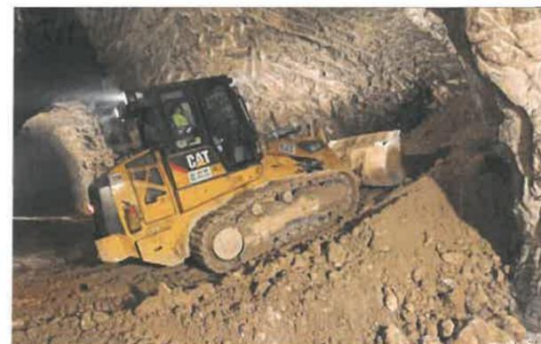
Remblayage total des galeries d'extraction en souterrain (track sur chenilles poussant les remblais de la galerie, carrière de Montmorency)
